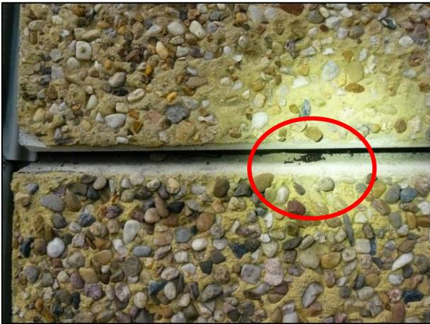
Abb. 14: Anhäufung von Kotpillen unter einem Tagesquartier einer kleinen Gruppe Zwergfledermäuse in einer Bauteilfuge
