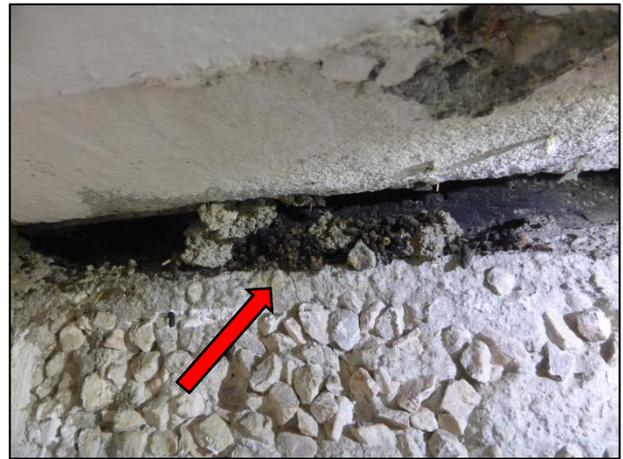
Abb. 21: Starke Kotablagerung in der oberen Anschlussfuge des Balkons nach Entfernung des unteren Schalbretts
