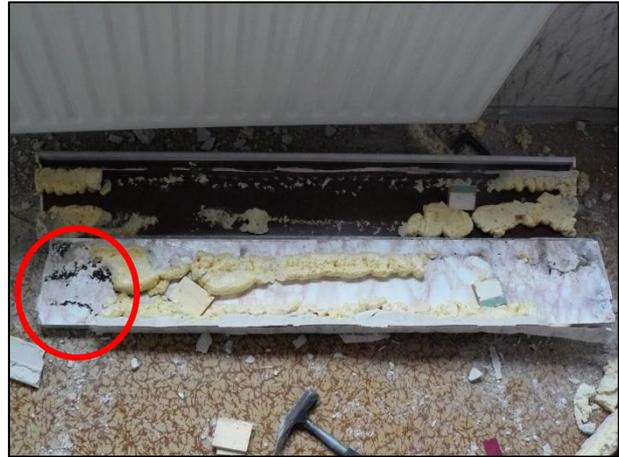
Abb. 12: BILD D: Einzelne Tiere drangen über die Rahmung vollständig in die Wohnung ein und saßen in einem Hohlraum zwischen den doppelt aufgebauten Fensterbänken (Rot die Kotpillen in der aufgebrochenen Innenfensterbank)
