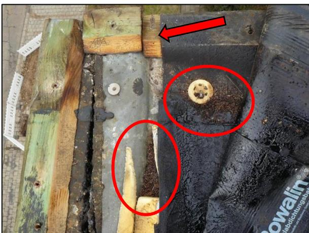
Abb. 26: Langjähriges Zwergfledermausquartier zwischen Dachbahn und Traufbohle mit massiven Kotablagerungen (Kreise) sowie der Einschluöffnung (Pfeil, leicht versetzt liegende Traufbohle)
