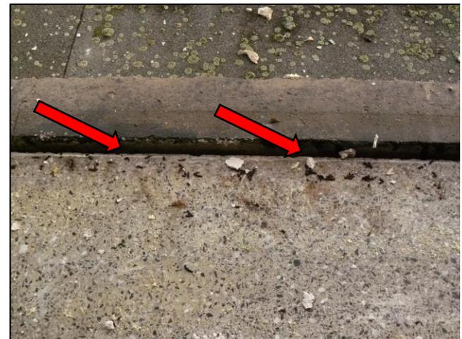
Abb. 10: BILD B: Weiterführender Spalt, um **unter** die steinerne Fensterbank zu gelangen
