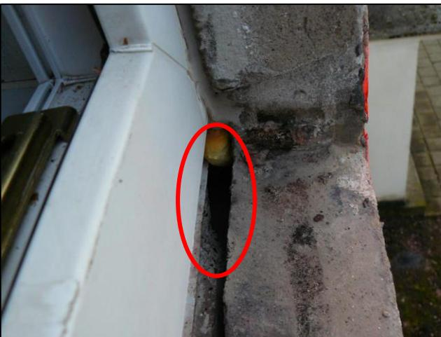
Abb. 9: BILD A: Einschlußöffnung, um in den Fensterrahmen und weiter zum **inneren** Fensterbrett zu gelangen
