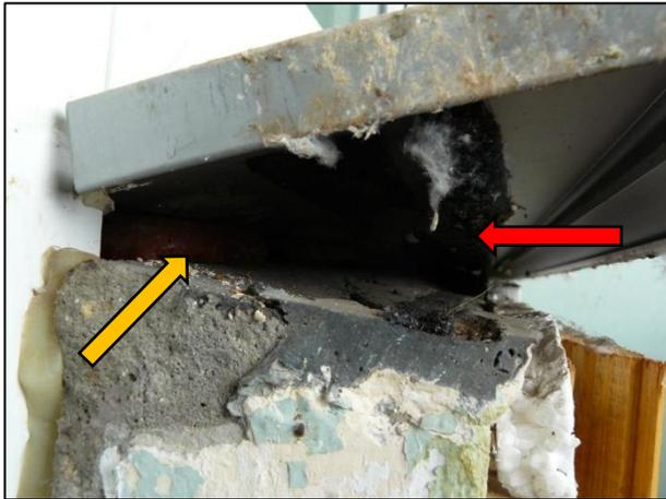
Abb. 1: Seitliche Profilansicht äußere Fensterbank mit Dichtband (rot) und gut ausgeschäumter Laibung (orange). Fledermäuse können hier trotzdem das verklebte Band unterwandern und im Zwischenraum vor der Laibung ruhend, **ganzjährig** angetroffen werden.
