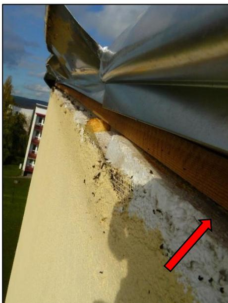
Abb. 22: Kotpillen auf dem Armierungsgewebe/Rauputz hinter der oberen Blechkante einer Dämmfassade mit deutlichem Einschluflspalt zwischen Dämmplatte und Lattung
